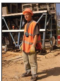
в строительно-монтажных работах
